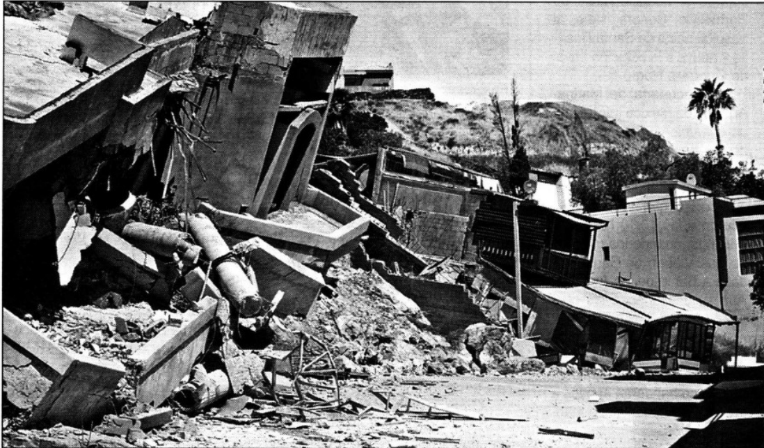
El presidente municipal de Tijuana, Baja California, Jorge Ramos, hizo ayer un recorrido por el fraccionamiento Monterrey, donde un deslave destruyó 11 casas y causó daños en ocho ■ Fotos Abel Colorado López
